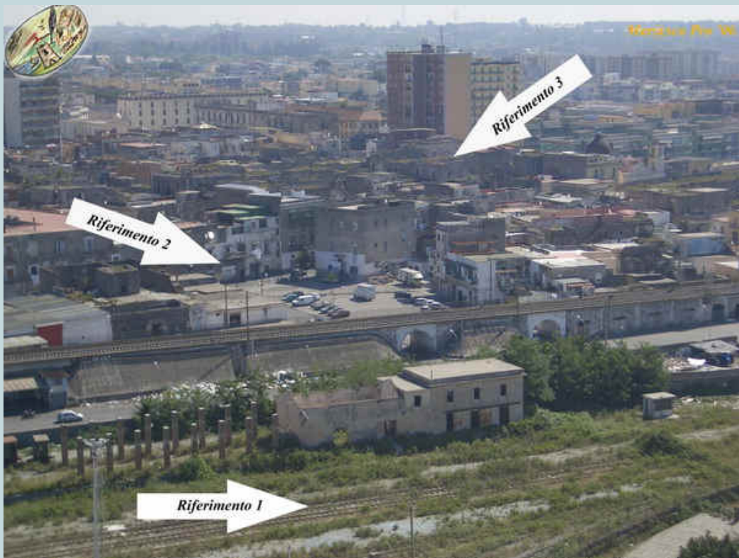
Foto 2 - Foto Aerea dell'area devastata dalle esplosioni, seguono i riferimenti:
